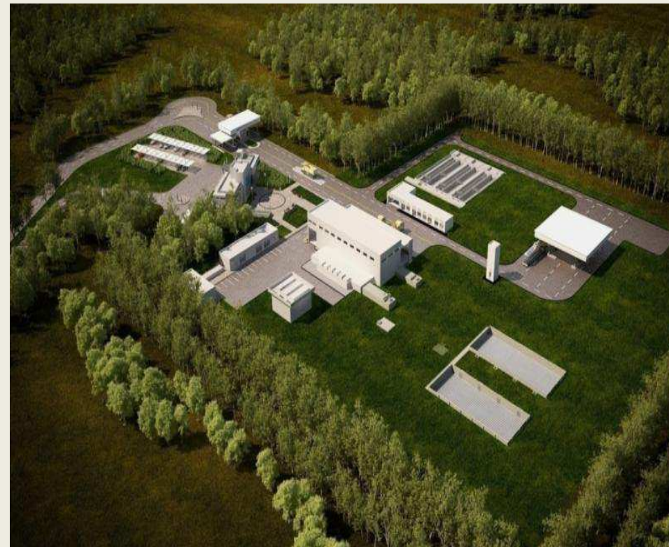
ESTACIÓN DEPURADORA DE AGUAS RESIDUALES (en ejecución )
