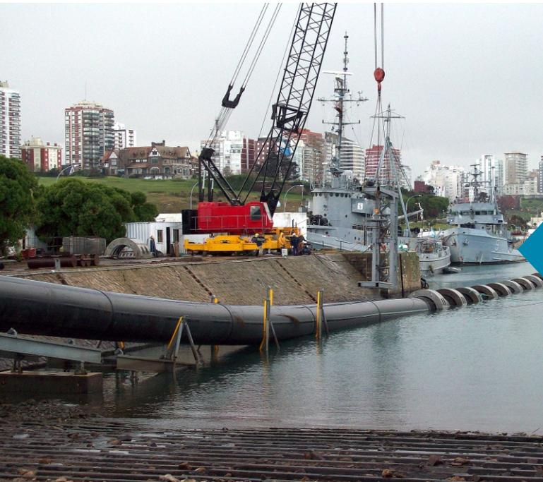
A cada tramo se le colocaron 150 contrapesos de hormigón armado de gran tonelaje, se le pusieron tapas de acero en sus extremos y gracias al aire encerrado en su interior, se pudieron acopiar flotando en el puerto hasta el momento instalación.
