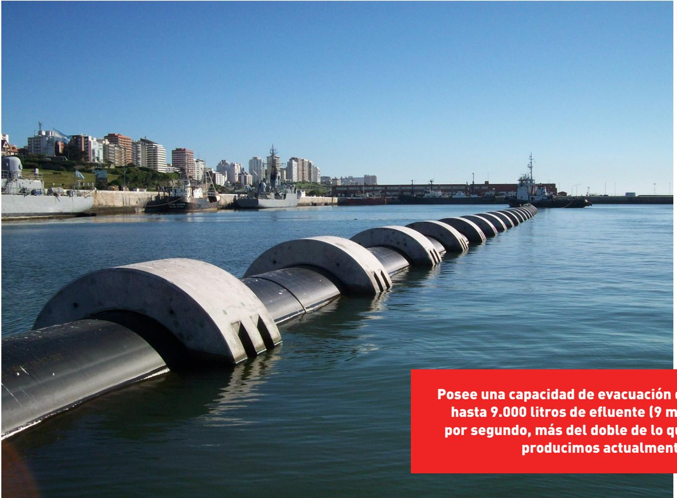
**Posee una capacidad de evacuación de hasta 9.000 litros de efluente (9 m3) por segundo, más del doble de lo que producimos actualmente.**
