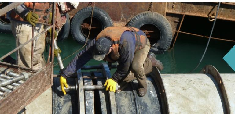
La instalación de la cañería en la zona "off shore" o mar afuera, se completó con la interconexión de cada uno de los tramos previamente sumergidos, mediante el empleo de tubos cortos o manguitos, de unos 10 metros de longitud cada uno, gracias al trabajo de buzos y el apoyo de equipos navales específicos, trabajando en aguas abiertas a más de 10 metros de profundidad.
