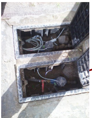
4 LOCALES EN PLANTA BAJA 2 CONEXIONES CON TOTALIZADOR 1 SIN ENLAZAR AMBOS CON TELEMETRIA-1 TANQUE RESERVA ELEVADO COMUN GABINETE ELECTRICO Y MEDIDORES EN ESPACIO COMUN DENTRO DEL INMUEBLE POR EXCEPCION EN RECINTO BAJO TECHO
