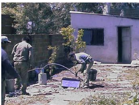
Foto 3: Limpieza de perforación
