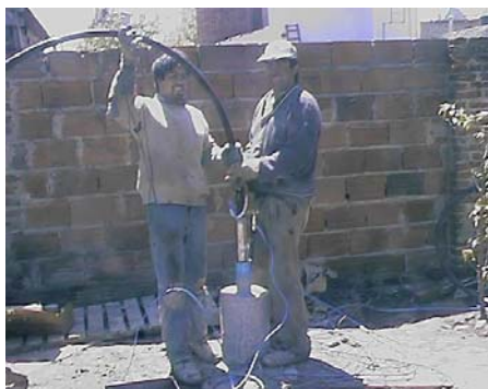
Foto 2: Instalación equipo de limpieza
