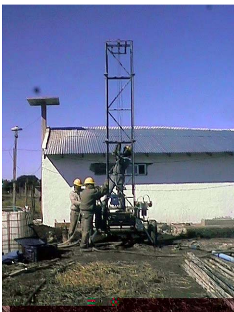
Foto 1: Trabajos de Rotación en pozo
