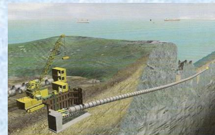
Esquema de una instalación de emisario desde la cima de un acantilado (Cortesía Herrenknecht AG)
